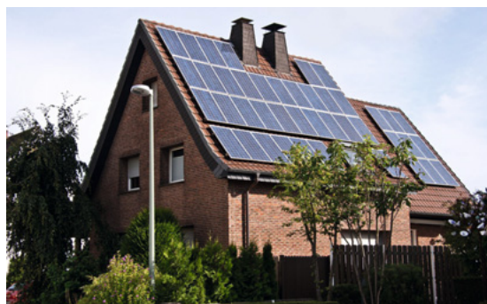
B1 Hausdach mit Silicium-Solarzellen
