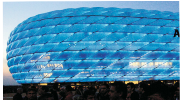
B2 Die Fassade der Münchner Sportarena ist aus ETFE, einem innovativen Kunststoff.
